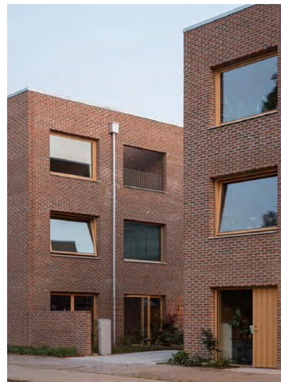
Rode baksteen als basis bij collectief woonproject Twelve Houses. Malmö (SE), Förstberg Ling Architecten
