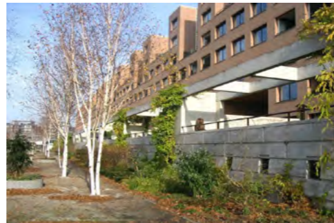
Dit grootschalige woningbouwproject in Maastricht aan de oevers van de Maas bevat een licht verzonken parkeergarage die landschappelijk is ingebed in het park. Wooncomplex Stoa, Maastricht, Luigi Snozzi
