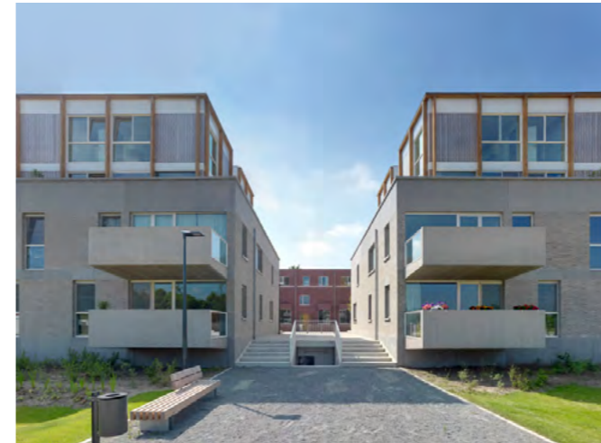
Doorgang tussen twee woongebouwen op een collectieve ondergrondse parkeergarage met entree's in het openbaar domein. Boechout, Kontich, BULK Architecten
