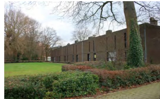
De bestaande rijwoningen worden afgebroken en (vrijwel) identiek teruggebouwd. In het verlengde is er nog plaats voor vier extra rijwoningen.
