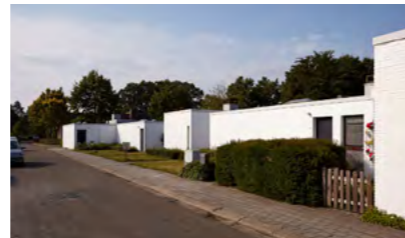
Zicht op de bejaardenwoningen toen ze nog bewoond en onderhouden werden. Bron: Inventaris Onroerend Erfgoed
