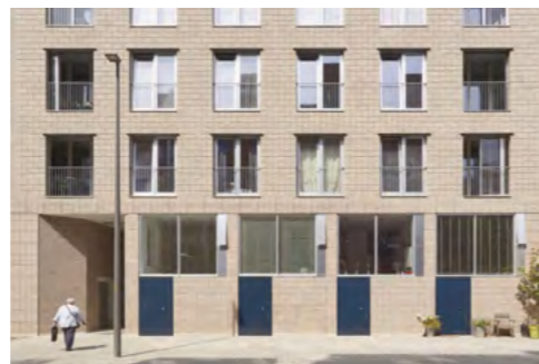
Gevel van een collectief woongebouw met een dubbelhoge eerste woonlaag die landt aan de straat. Cadixwijk Antwerpen, Ono Architectuur
