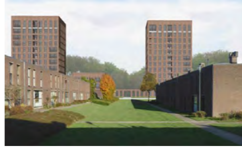
Render van de parkappartementen, momenteel in aanbouw in de Parkwijk. Turnhout, AWG architecten
