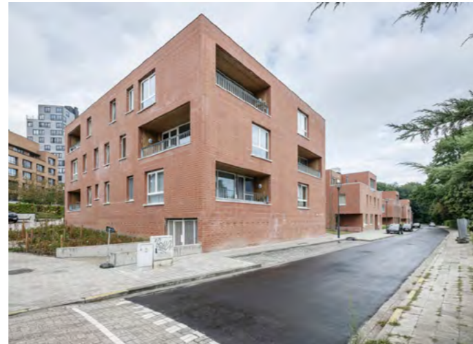
Boven: ensemble van drie collectieve stadsvilla's met groene tussenruimte in opdracht van Woonboog (toen nog De Ark). Sociale woningen Anco Site, Turnhout, BULK Architecten
